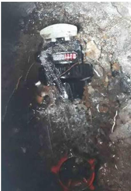
*De la información anterior se puede concluir que efectivamente si se presentó una fuga en el medidor del predio. Por consiguiente, el día 21 de septiembre de 2018 se realizó la reparación de dicha fuga y se instaló el nuevo medidor No. J18FA800389*
